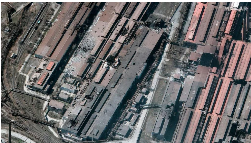
Figura 24. Imagen satelital de daños en los edificios de la fábrica metalúrgica Azovstal en Mariúpol, Ucrania, en marzo de 2022. Tecnologías Maxar. Fuente: https://www.c4isrnet.com/battlefield-tech/space/2024/05/06/national-geospatial-intelligence-agency-creating-space-intel-hub/
