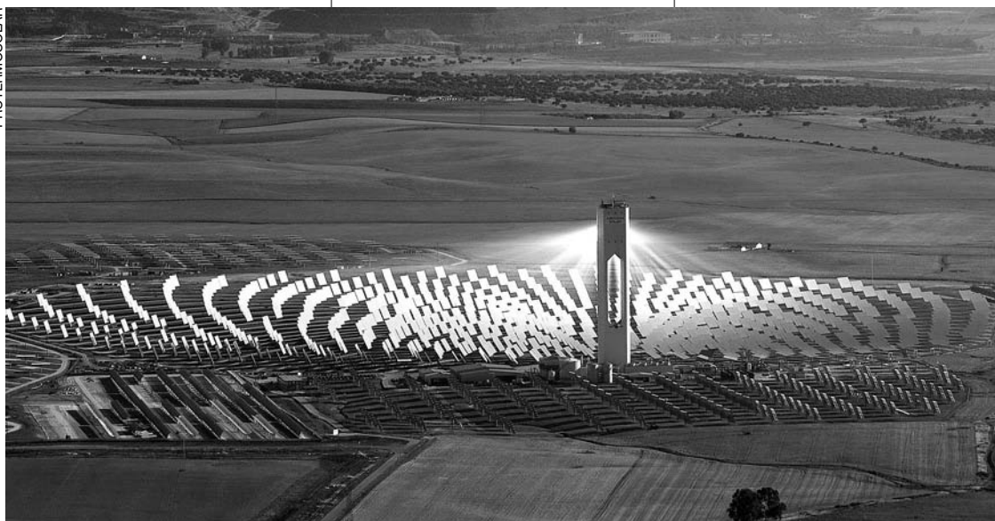
Planta termosolar de torre central con heliostatos fijos de Sanlúcar la Mayor (Sevilla), la primera del mundo en su especie.
