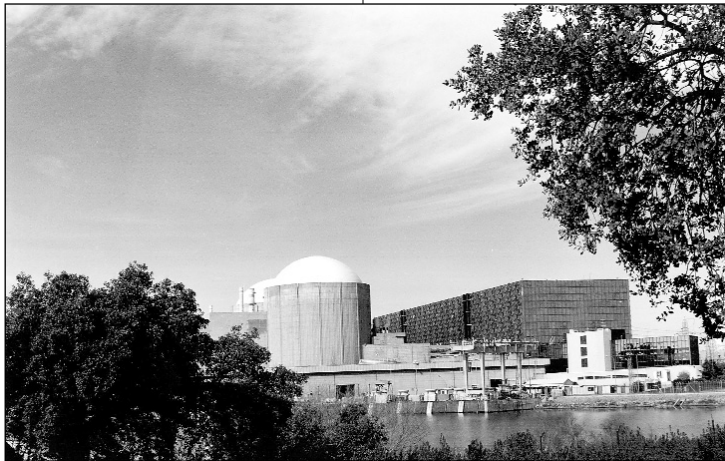
El Consejo de Seguridad Nuclear gestiona el sistema español de vigilancia radiológica medioambiental. En la imagen, la central nuclear de Almaraz (Cáceres).
